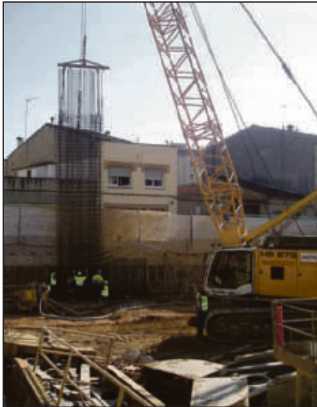
Col·locant les pantalles de forjat.
