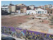
Espai que ha deixat l'enderrocament del Vapor Cusidó
