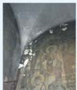
Imatges dels frescos degradats per la humitat i la manca de conservació.
